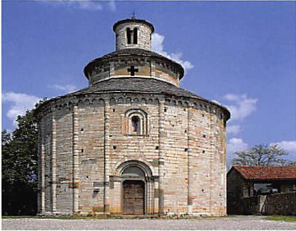
(Vista frontale della Rotonda di San Tomè)
